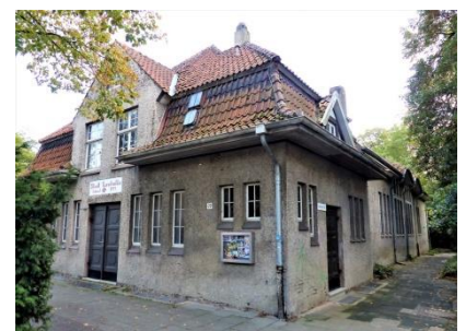
Die Turnhalle Lübberbruch von 1911
